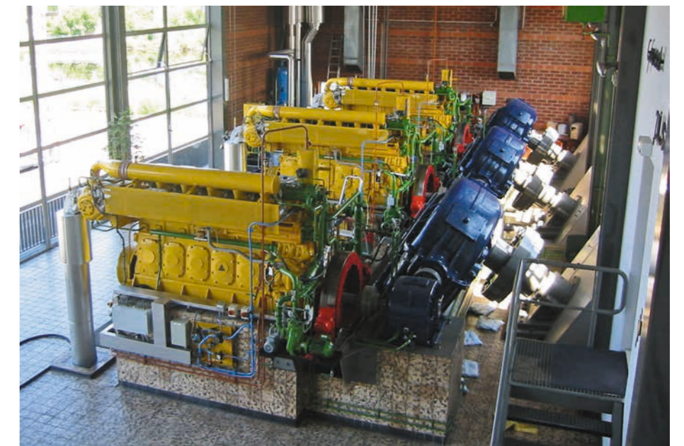
Dieselaandrijving in gemaal J.U. Smit.
