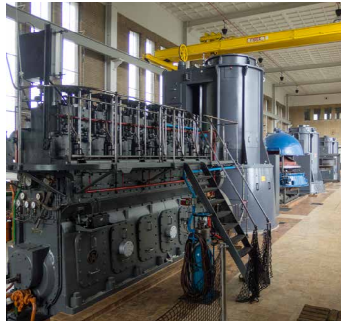
Hybride aandrijving gemaal Pijnacker Hordijk.
