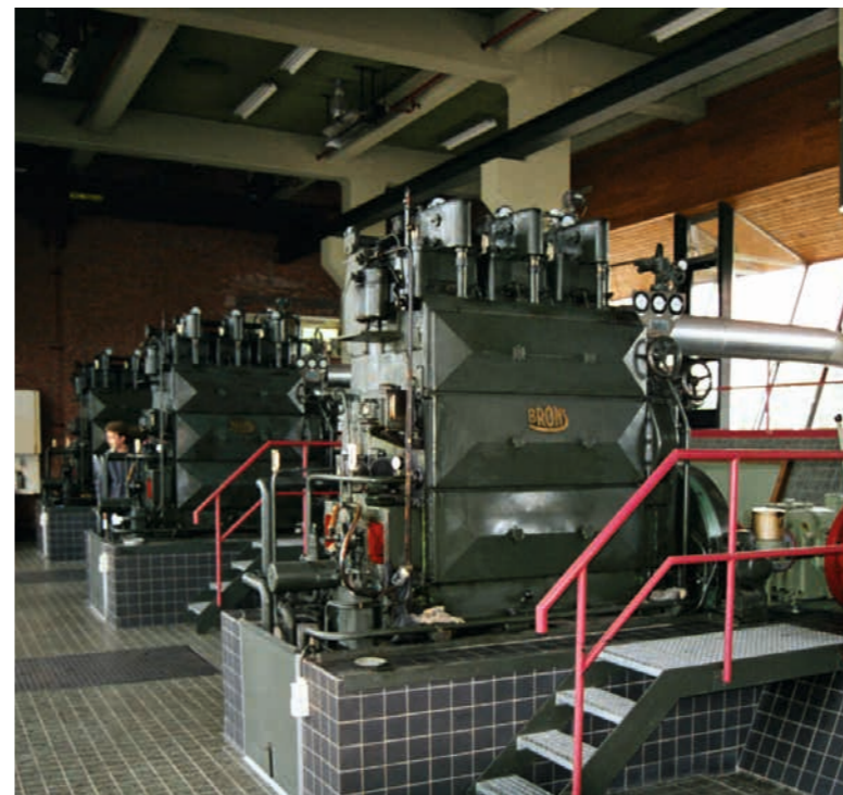
Dieselaandrijving in gemaal H.D. Louwes.
