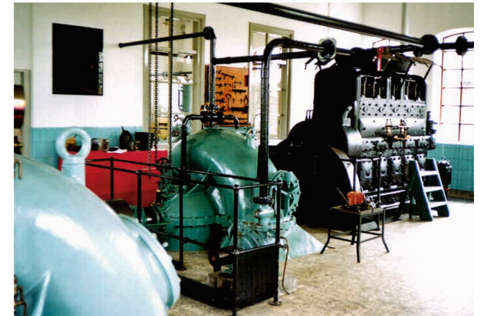
Dieselaandrijving in gemaal Middelpolder.
